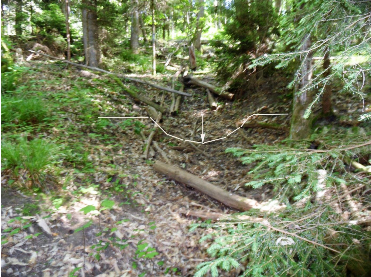
Eines der vier Pingenfelder im Rahlsbach (Pingen sind kesselförmige Vertiefungen, die durch eingestürzte Stollen entstanden sind).
