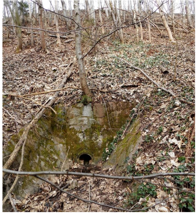
Der Stolleneingang auf der Südseite wurde in Folge der Rebumlegung zugemauert.
